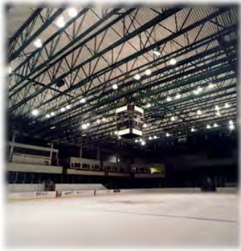
400-watt metal halide
